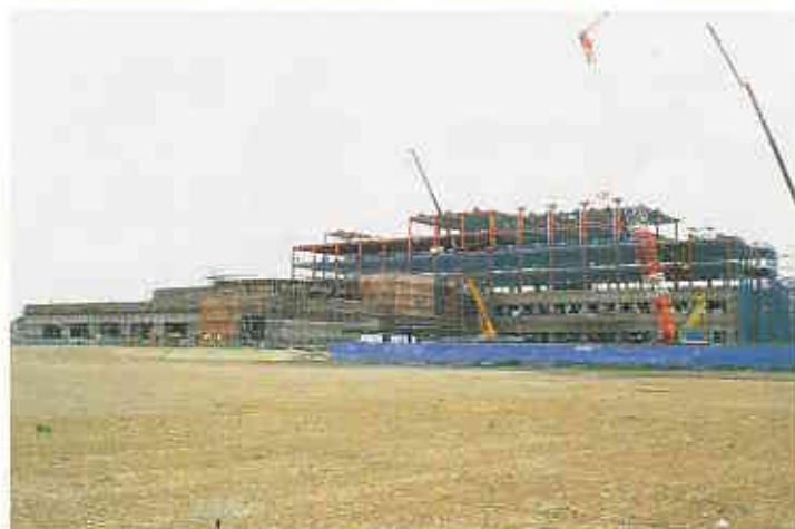
新病院建設現場① (H17.4.14：南側より撮影)
