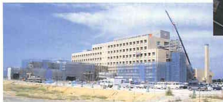
南東からみた本館棟
